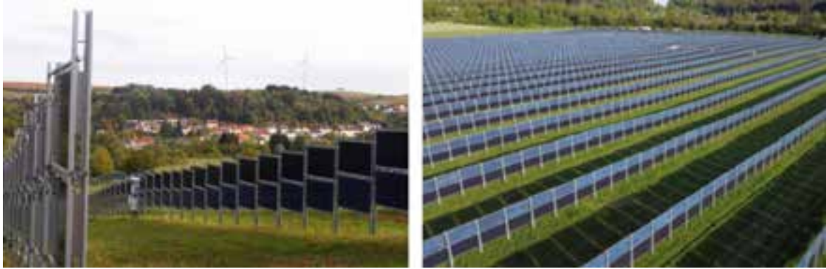
Fig. 43 - Moduli installati verticalmente. Fonte sito Nextsun 29 .
