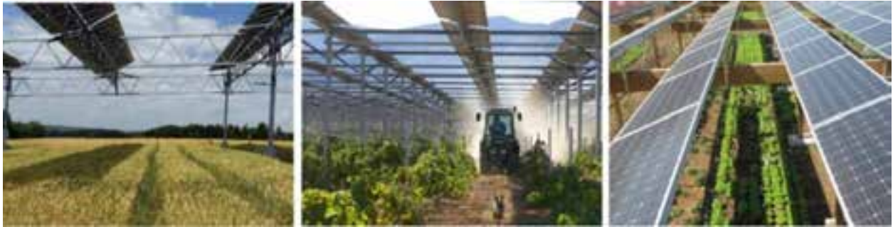
Fig. 46 - Esempio di attività agricola diretta (generatori a inclinazione fissa esposti a sud. Da: Fraunhofer ISE.
