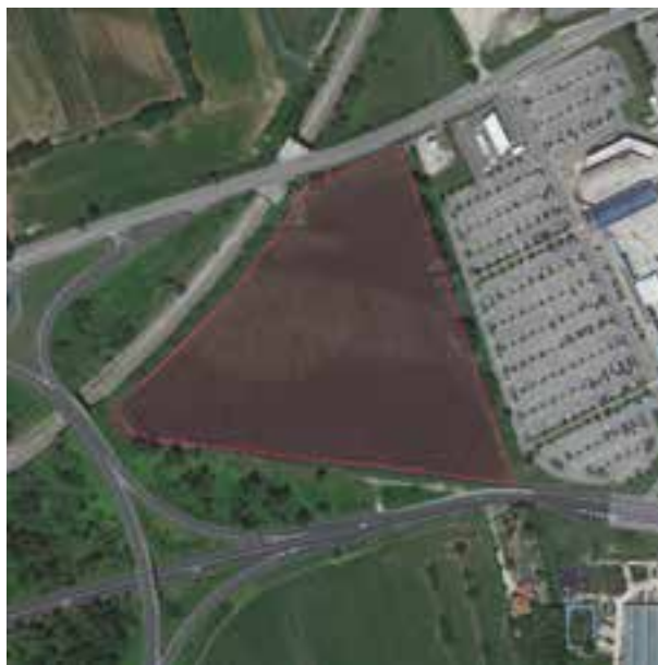
Fig. 2 - Immagine satellitare di inquadramento della proprietà oggetto di intervento.
